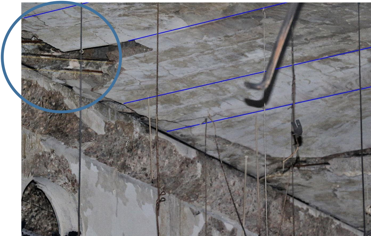
Voorgespannen wapening ligt volledig bloot. Ter plaatse van de oplegging is de vloer geknikt. Zie de hoek van de wapening ten opzichte van vloerplaat.
