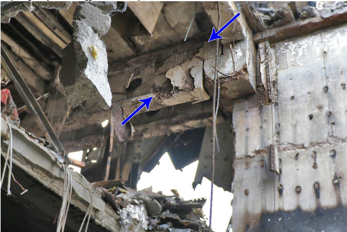
Oplegging betonnen ligger (opleg nok) wordt enkel door wapening bij elkaar gehouden. Constructieve sterkte is sterk afgenomen.
